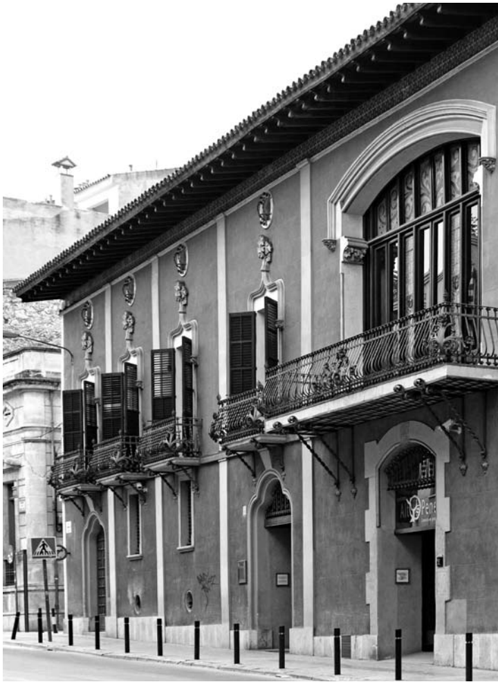
◀ La façana actual data de les reformes efectuades a la casa l'any 1903
