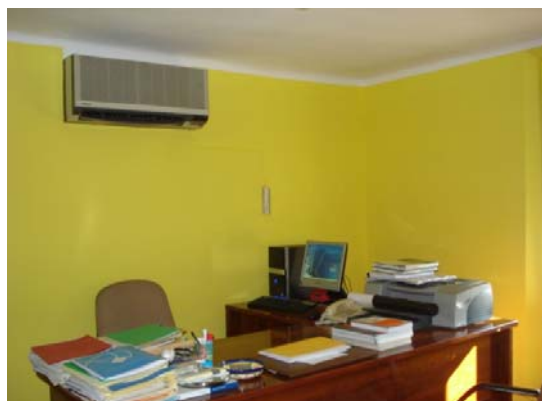
Fotografia 4: Aire condicionat. (Font: Elaboració pròpia. Any 2011)
