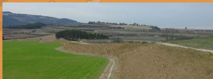
Talús suau amb terra vegetal estesa, preparat per a ser revegetat.
