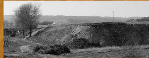
Formació de talussos en una esplanació.
